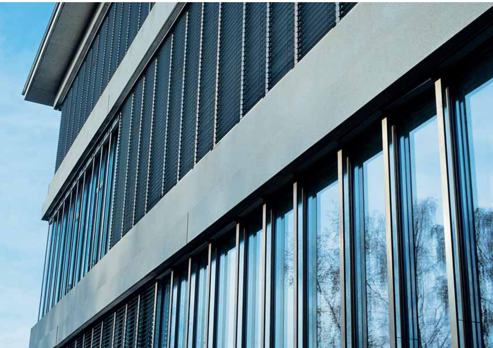
Baubronze besitzt hohe Zug- und Druckfestigkeit. Ihr spezifisches Gewicht ist mit Stahl vergleichbar. Tiefe Wärmedehnungswerte ermöglichen den Einsatz von Bronzeprofilen an exponierter Lage und für Fassadengestaltungen im Hightechbereich. Resistent gegen Korrosion, ist Baubronze auch der ideale Werkstoff in klimatisch anspruchsvollen Regionen.
